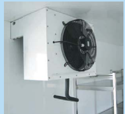
Einbausituation Huckepack-Aggregat (Verdampfer)
